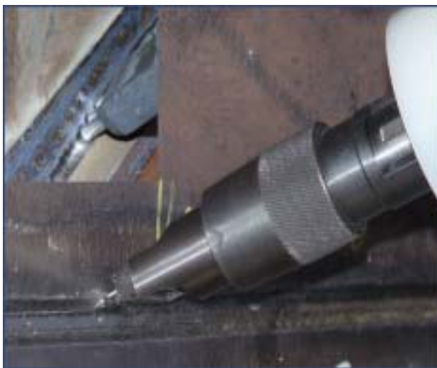
Bild 4. Behandlung einer Schweißnaht
