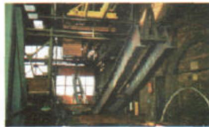
Bild 4a - 4e. Krümmen einer Stahlbrücke durch das Flammrichten. Die Durchbiegung der Profile beträgt 4,12 Meter.
