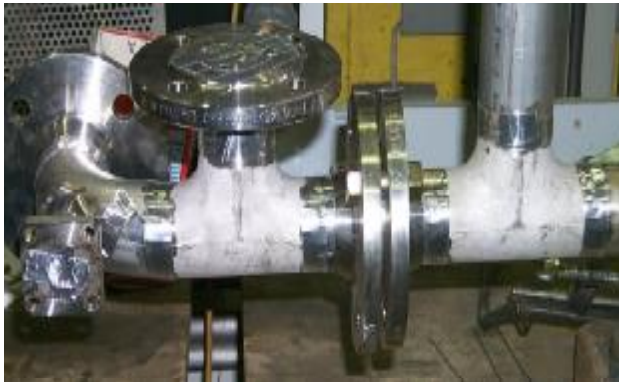
Bild 5. Zum Schweißen vorbereitete Rohrleitungsisometrie aus CrNi-Stahl
