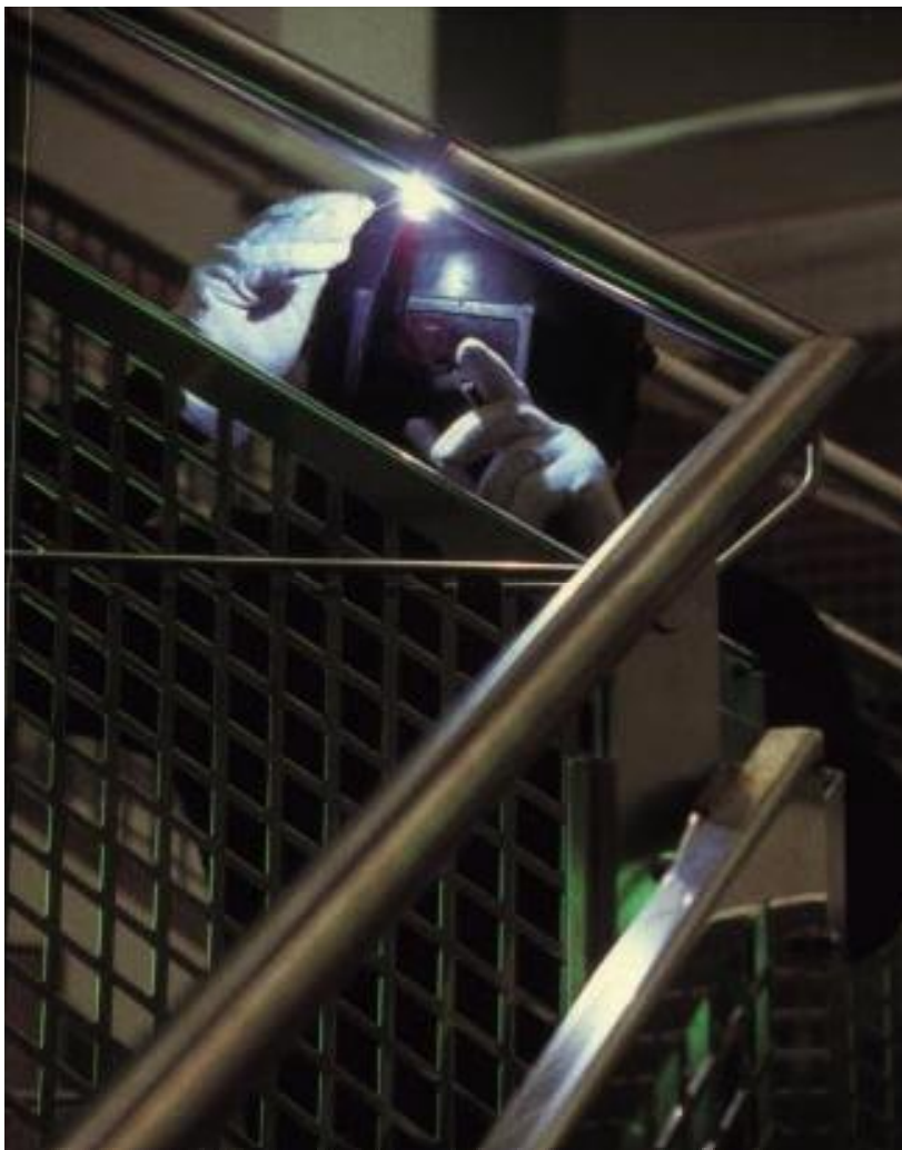
Bild 14: WIG-Schweißen auf der Baustelle
